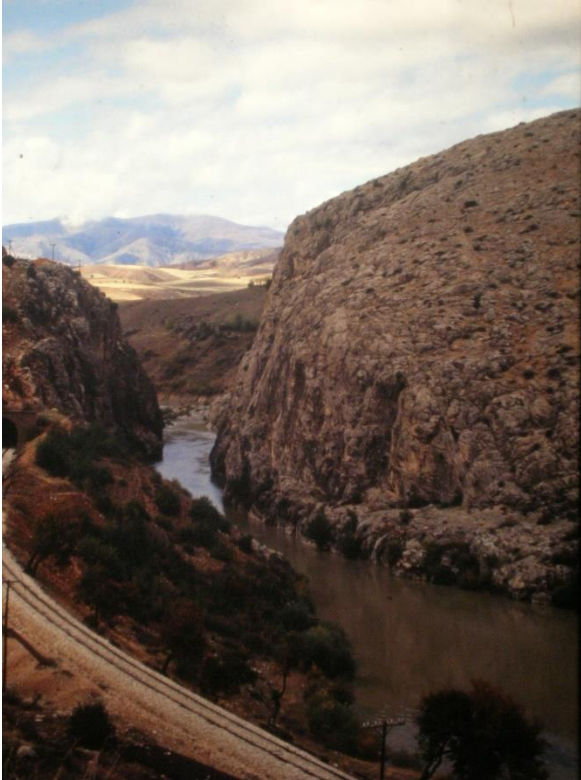
Kemah Boğazı. Kuzeyde Demiryolu.
